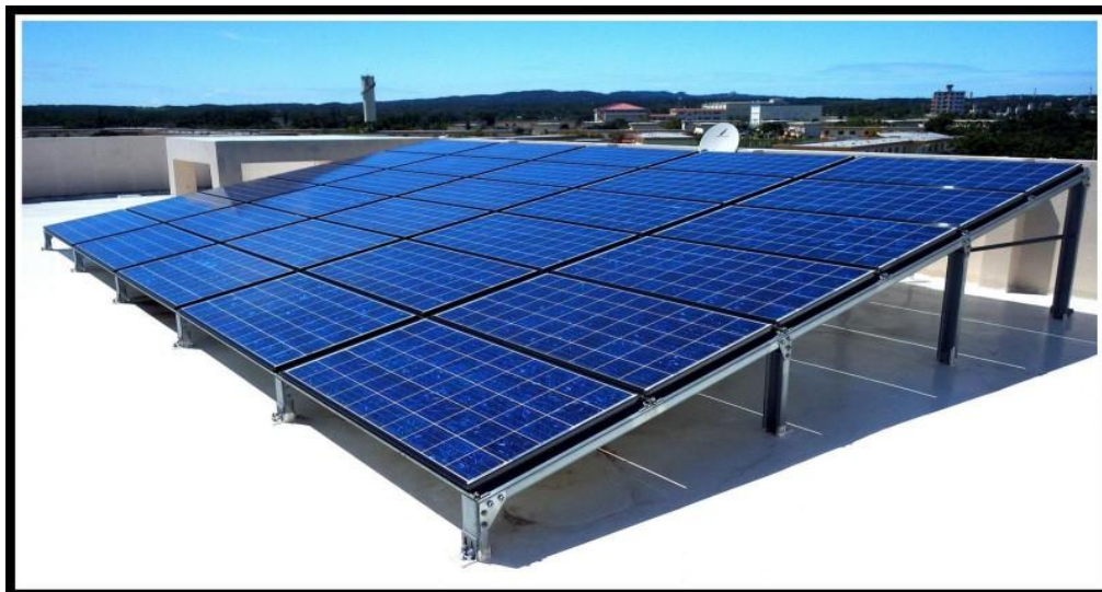
شکل (۶) استفاده از پنل خورشیدی در ساختمان
