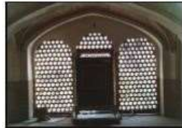
شکل شماره (۱۳): تهویه عبوری و سایه اندازی پنجره های مشبک چوبی
