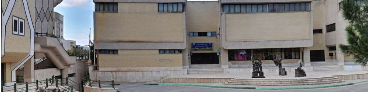
شکل ۴- ساختمان دانشکده هنر و معماری زابل. مأخذ: http://uoz.ac.ir .
