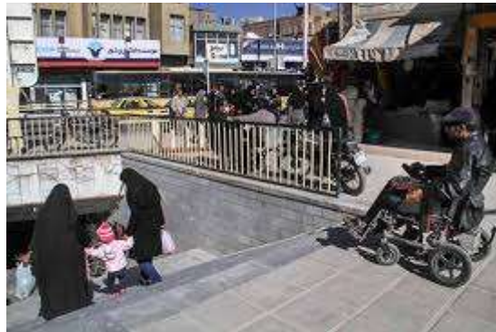
تصویر (۴) عدم تناسب ساخت پله برای حرکت معلولین
