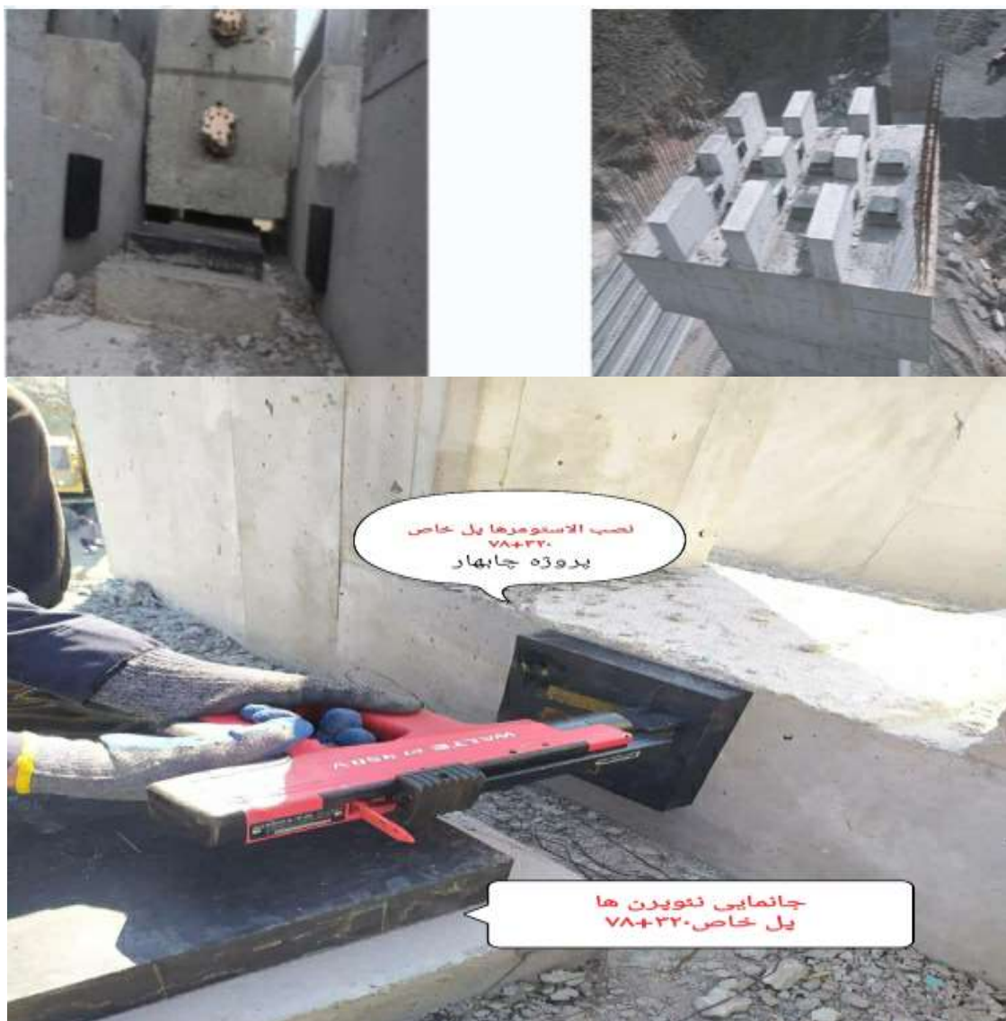
شکل شماره (۶): موقعیت استاپ‌بلاک، نصب الاستومر و جانمایی نئوپرن پل خاص کیلومتر ۷۸+۳۲۰ (۴*۳۰) از مسیر قطعه ۲ پروژه احداث راه آهن چابهار به زاهدان
