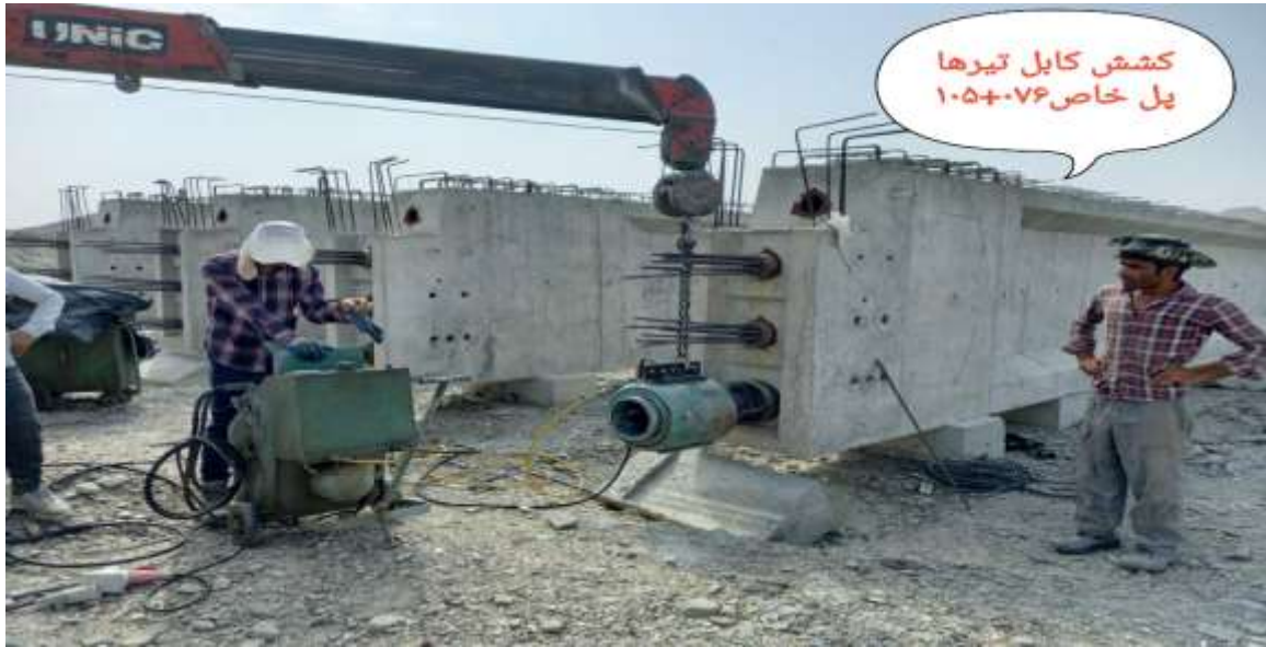
شکل شماره (۸): کشش کابل تیرهای پل خاص کیلومتر ۰۷۶+۱۰۵ (۳۰*۶) از مسیر قطعه ۲ پروژه احداث راه آهن چابهار به زاهدان
