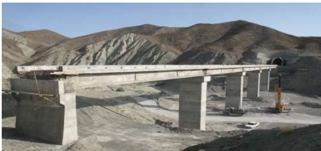
شکل شماره (۴): پل خاص کیلومتر ۳۶۵+۱۰۱ (۳۰*۵) از مسیر قطعه ۲ پروژه احداث راه آهن چابهار به زاهدان
