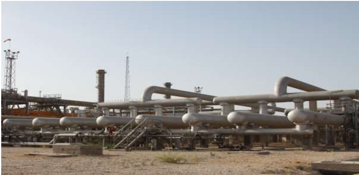
شکل شماره (۳) : واحدهای تفکیک گاز ورودی پالایشگاه، مأخذ: پالایشگاه گاز فجر، واحد آموزش
