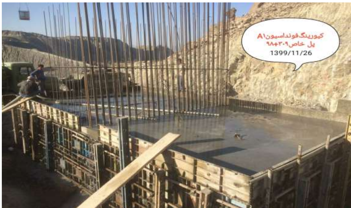
شکل شماره (۱): کیورینگ بتن از مسیر قطعه ۲ پروژه احداث راه آهن چابهار به زاهدان
