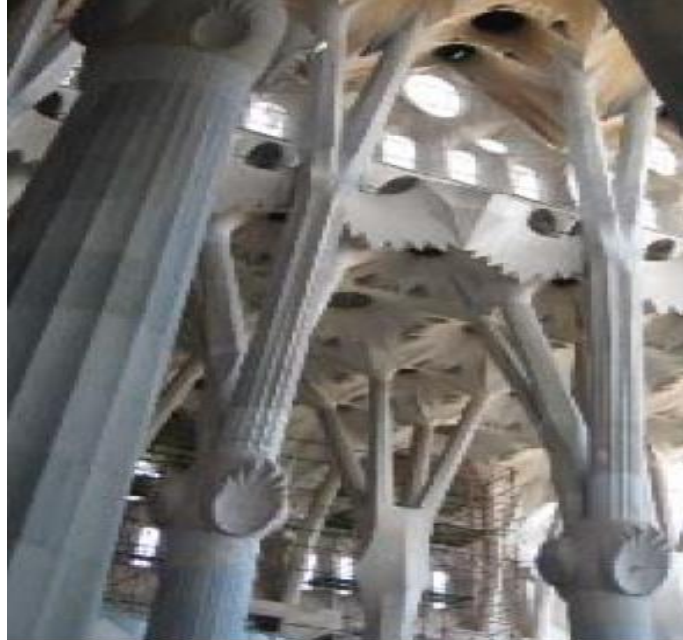
تصویر شماره ۱: کلیسای ساگراد فامیلیا اثر آنتونی گائودی، ستون ها با الهام از شاخه های درختان. (Isaac:۲۰۰۸،۹)
