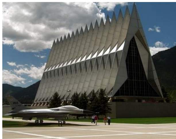
کلیسای cadet در آمریکا با استفاده از ورق های تا شده. www.salesway.ir
