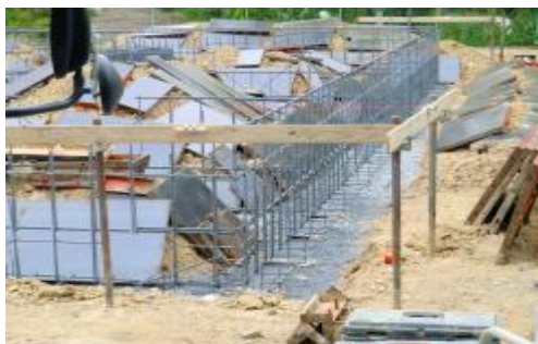
شکل ۱) زمینه سازی یک ساختمان: قفس مونتاز برای بتن مسلح
