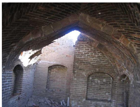
شکل (۱۲): تنگ گذاری نمای شمالی
