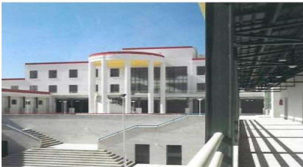
شکل ۱- دید به حیاط و پله‌های ورود به حیاط شمالی پروژه (مارگولیوس، ۱۳۸۸).
